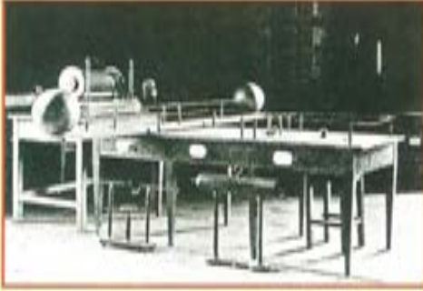
Hertz'in osilatörü yükü ve birbirine bağlı iki bakır küreden oluşuyordu.
